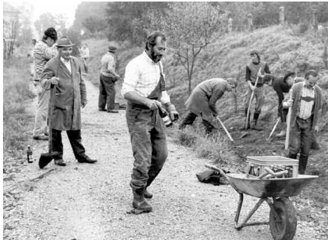
Die Arbeiten am Bahndamm durch die Vereinsmitglieder dem heutigen Rentnerweg
